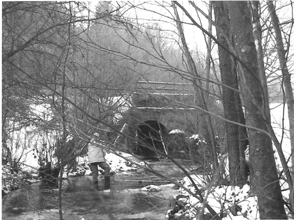
MP 3 am 02.02.06: Blick aus östlicher Richtung zur Brücke
