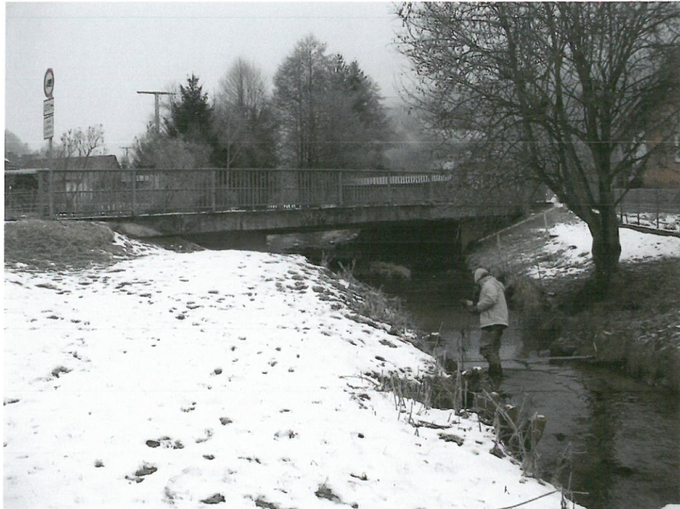
MP 8 am 02.02.06: Blick aus südlicher Richtung zur Brücke
