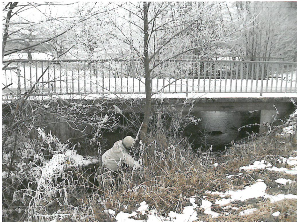
MP 7 am 02.02.06: Blick aus südlicher Richtung zur Brücke
