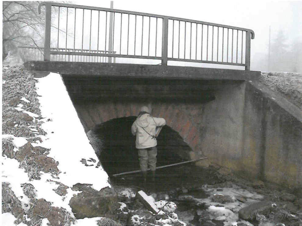
MP 9 am 02.02.06: Blick aus südöstlicher Richtung zur Brücke
