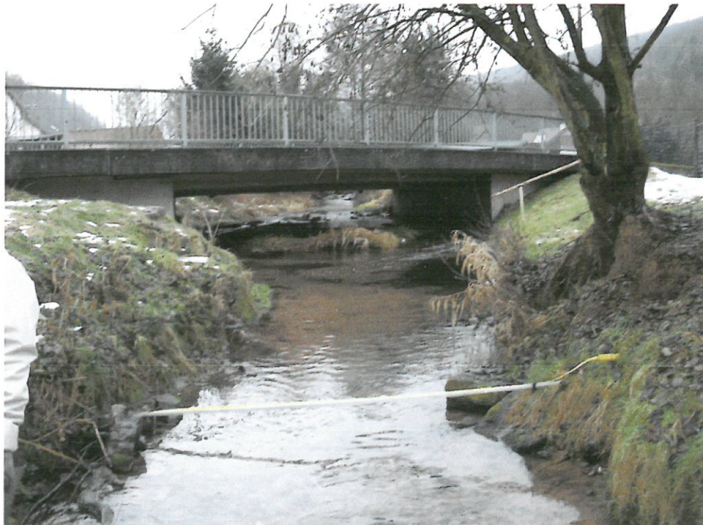
MP 8 am 07.02.06: Blick aus südlicher Richtung zur Brücke
