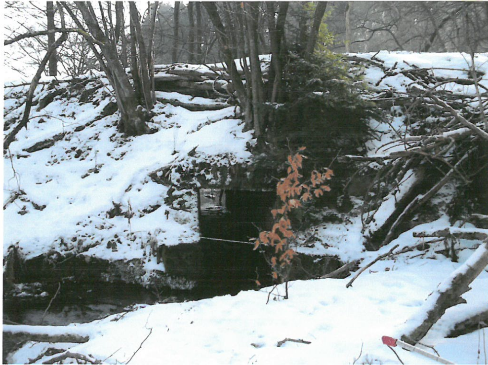
MP 1 am 02.02.06: Blick aus nördlicher Richtung zur Brücke
